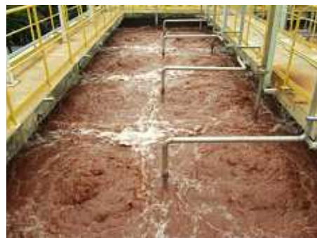
H24年 タイラヨン インド ADITYA BIRLA エポキシ工場
